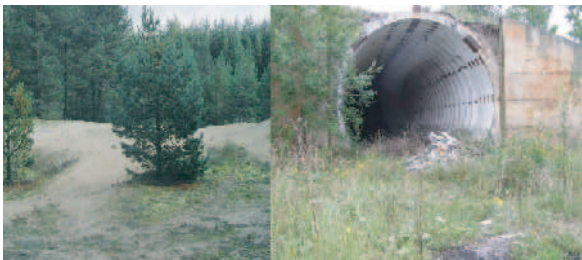
Kaitseliidu lasketiir 1930-test aastatest Kullamaal Raketišaht Pullapääl nõukogude okupatsiooni ajast
