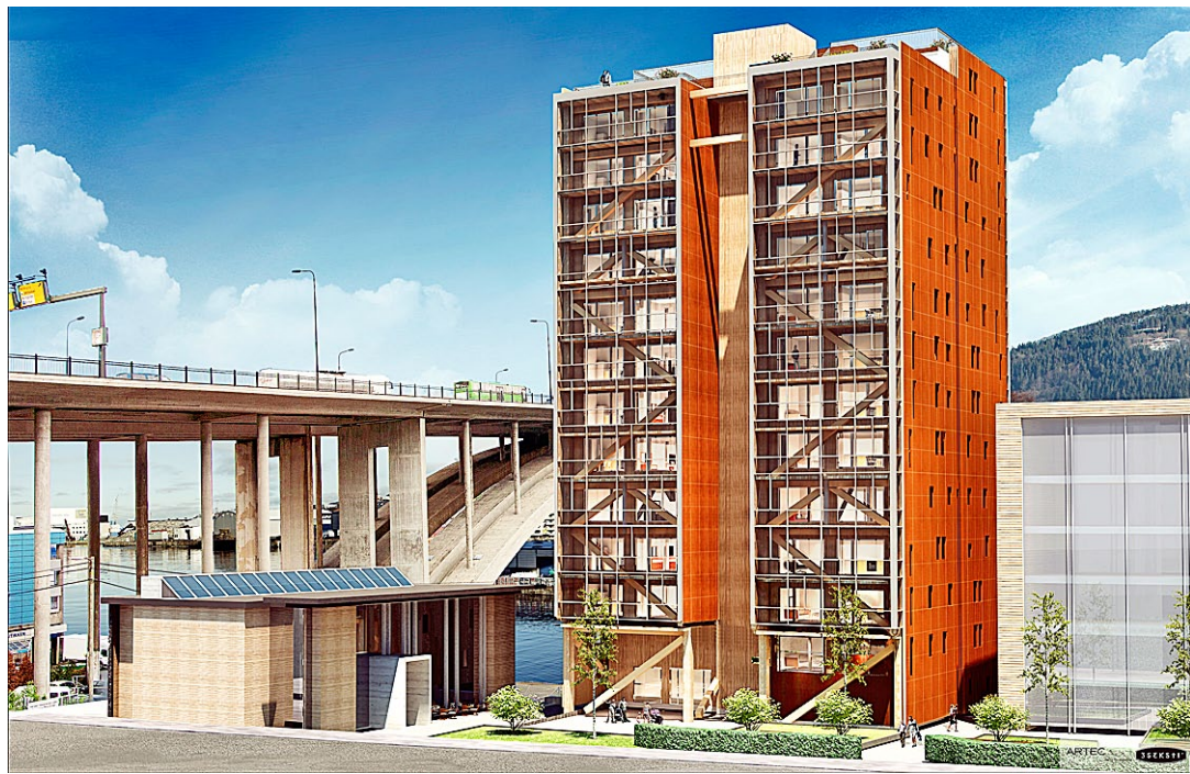
Maailma kõrgeim puitmaja, 14-korruselise korterelamu TREET kerkib Norras Kodumaja ASI toodetud moodulitest. Ehitusplatsile tuuakse siseviimistlusega ja osalt möbleeritud moodulid, kohapeal tehakse üksnes torustike ja juhtmete liited ning viimistletakse moodulite ühenduskohad.
