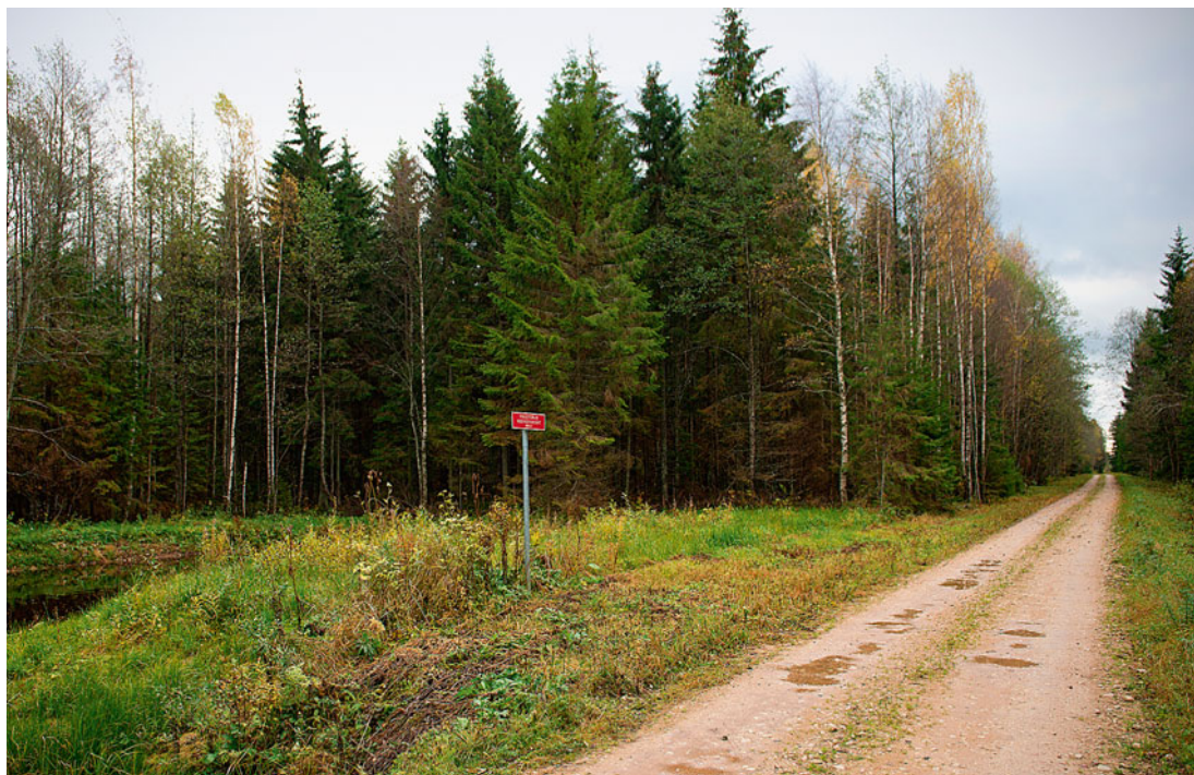
2011. A REKONSTRUEERITUD TULETÖRJE VEEVÕTUKOHT LIIVAKU-MÕISAASEME TEE ÄÄRES, PAUNKÜLA METSANDIK.
