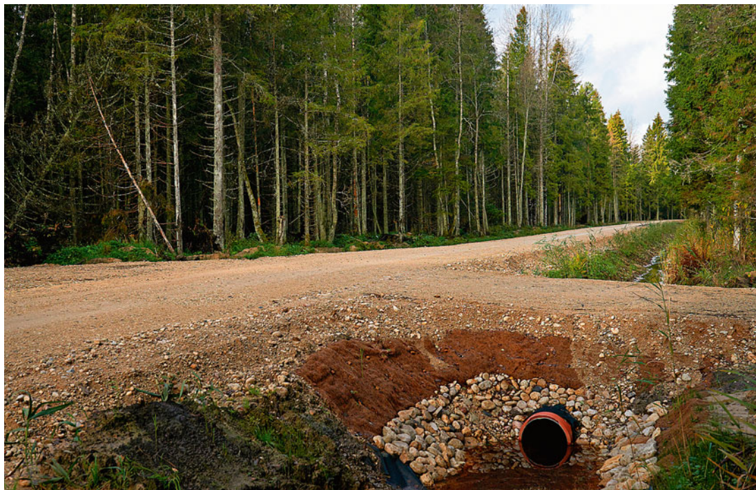
2012. A TEE-EHITUSE OBJEKT – POLDRI TEE, TUHALA, SAKU METSANDIK.
