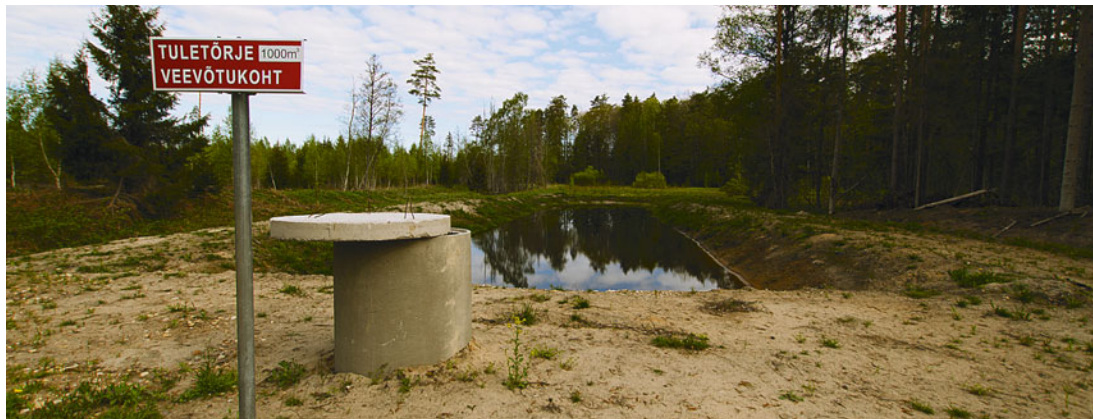
SÄLGO TEEL OLEV TULETÖRJE VEEVÕTUKOHT, AAKRE METSANDIK.
